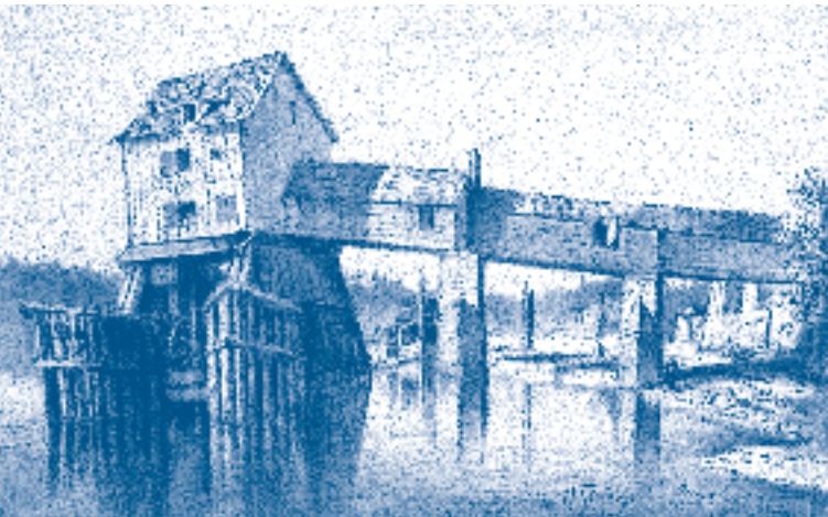
Dessin de François-Julien DECOURBE (1810-1889), Le moulin Saint-Sauveur en aval du Pont-aux-Moulins (1838).
