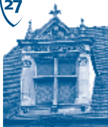
Détail d'une fenêtre
